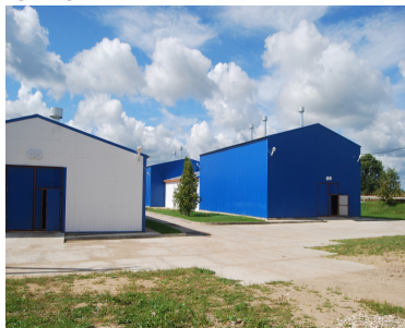
Рис.1. Общий вид завода
